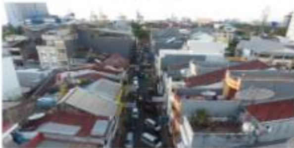
Kondisi Kapasitas Kendaraan di Jalan Semberu Caya
